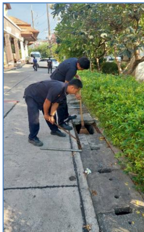
ภาพถ่ายที่ 2.2-9 การทำความสะอาดระบบระบายน้ำ
