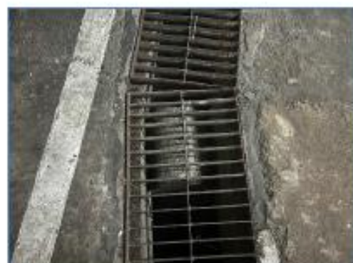
ชุดบำบัดน้ำเสียเบื้องต้นจากอาคารและตะแกรงดักเศษวัสดุก่อนมีสูบลำบายลงสู่ท่อระบายน้ำทิ้งรวมของเทศบาลเมืองป่าตอง
